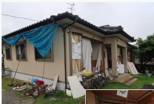
(上)平屋の建物が桁行方向に大きく傾いて全壊した。
